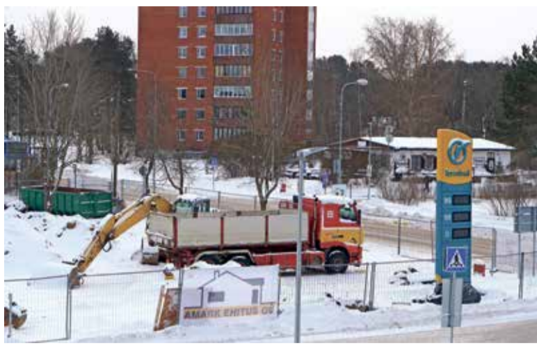
Строительство заправки Terminal Oil. Фото: Алар Таса
