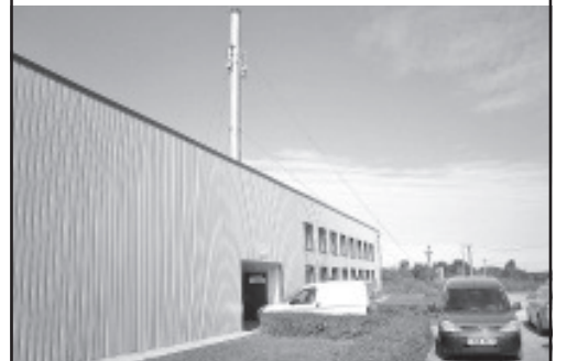
Olgina uus katlamaja. Foto: SW Energia
